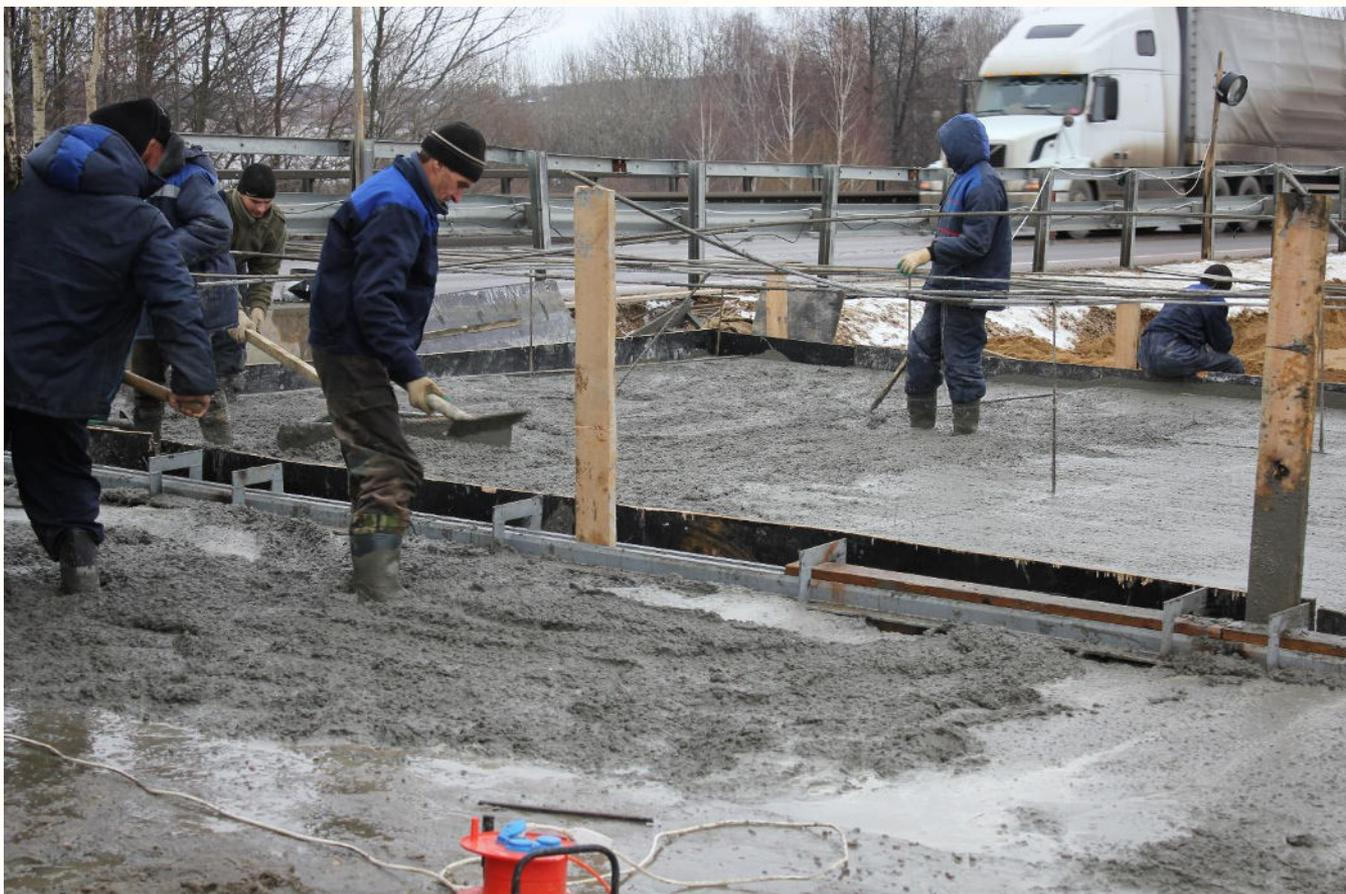
Омоноличивание деформационного шва (а/д М6- «Каспий», 2013 г)
