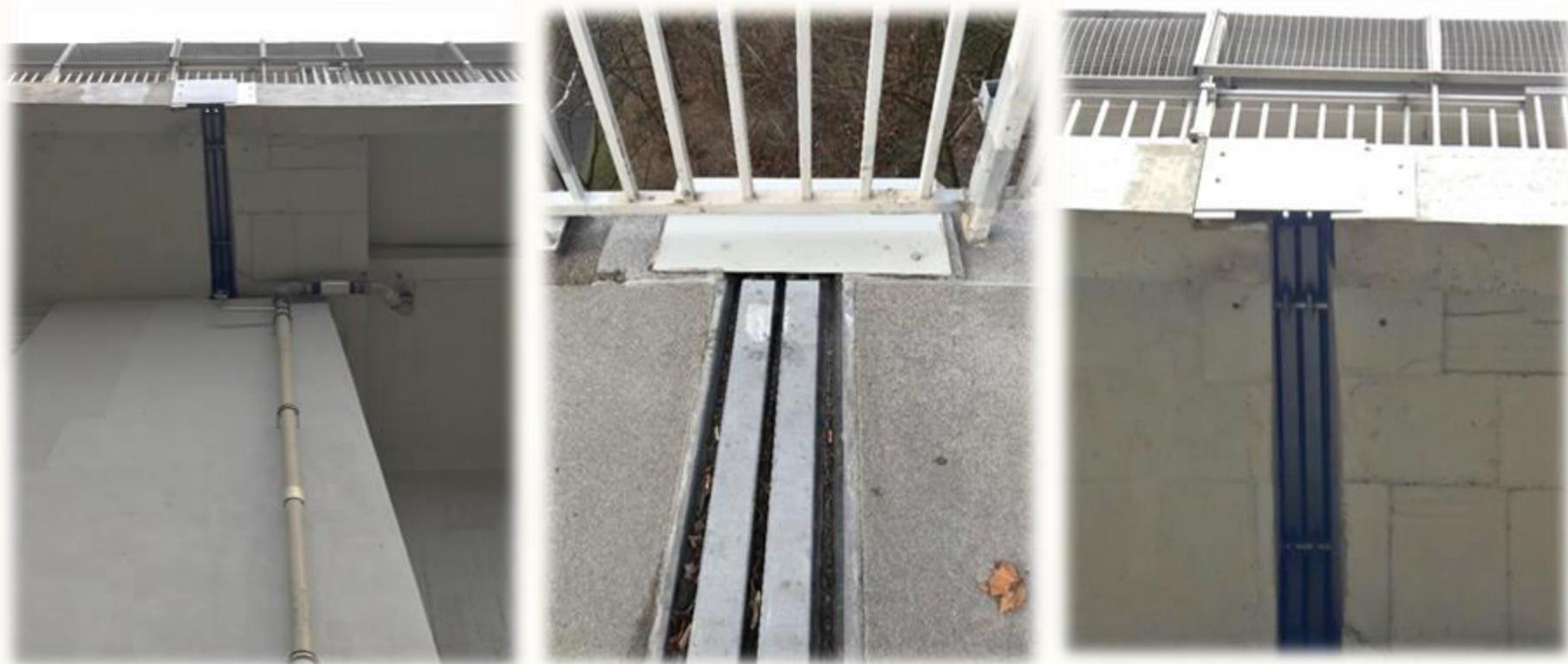
Современные конструктивные решения по организованному водоотводу в зоне деформационных швов
