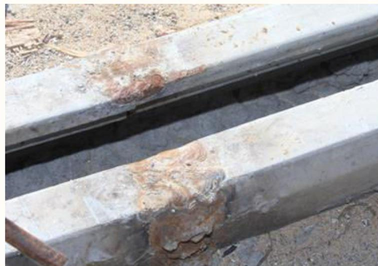
Состояние деформационных швов и околошовных зон покрытия спустя 1,5 года после ввода в эксплуатацию
