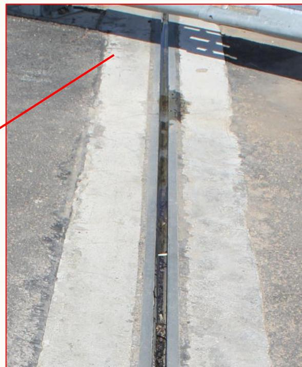
Застой воды, загрязнение компенсатора в зоне полосы безопасности на этапе ввода сооружения в эксплуатацию
