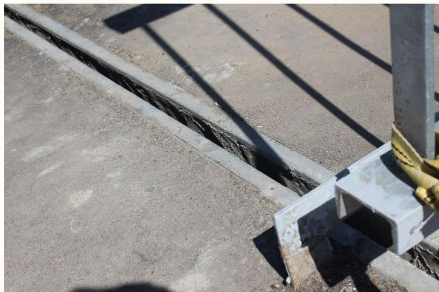
Наличие пустот под несущим профилем шва после его омоноличивания
