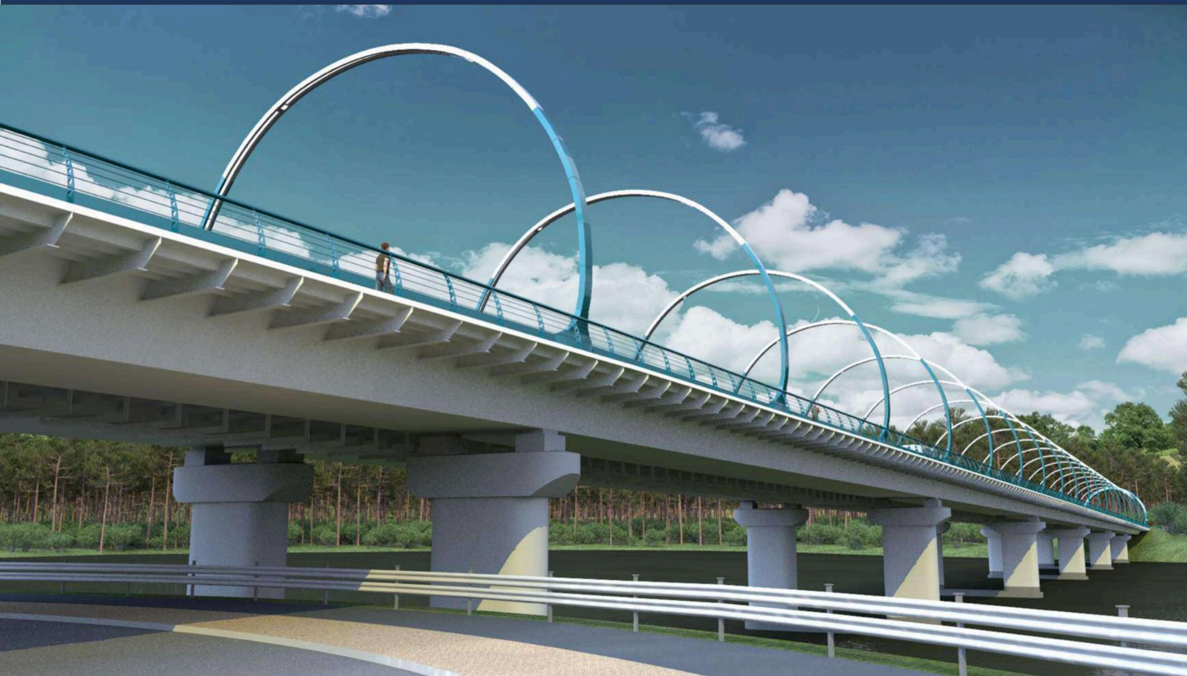
Главной особенностью конструкции моста стало металлическое из стали 15ХСНД-2 неразрезное криволинейное в плане пролетное строение с ортотропной плитой по схеме 45,8+6х63м, с полной длиной оси 424,6 м.
