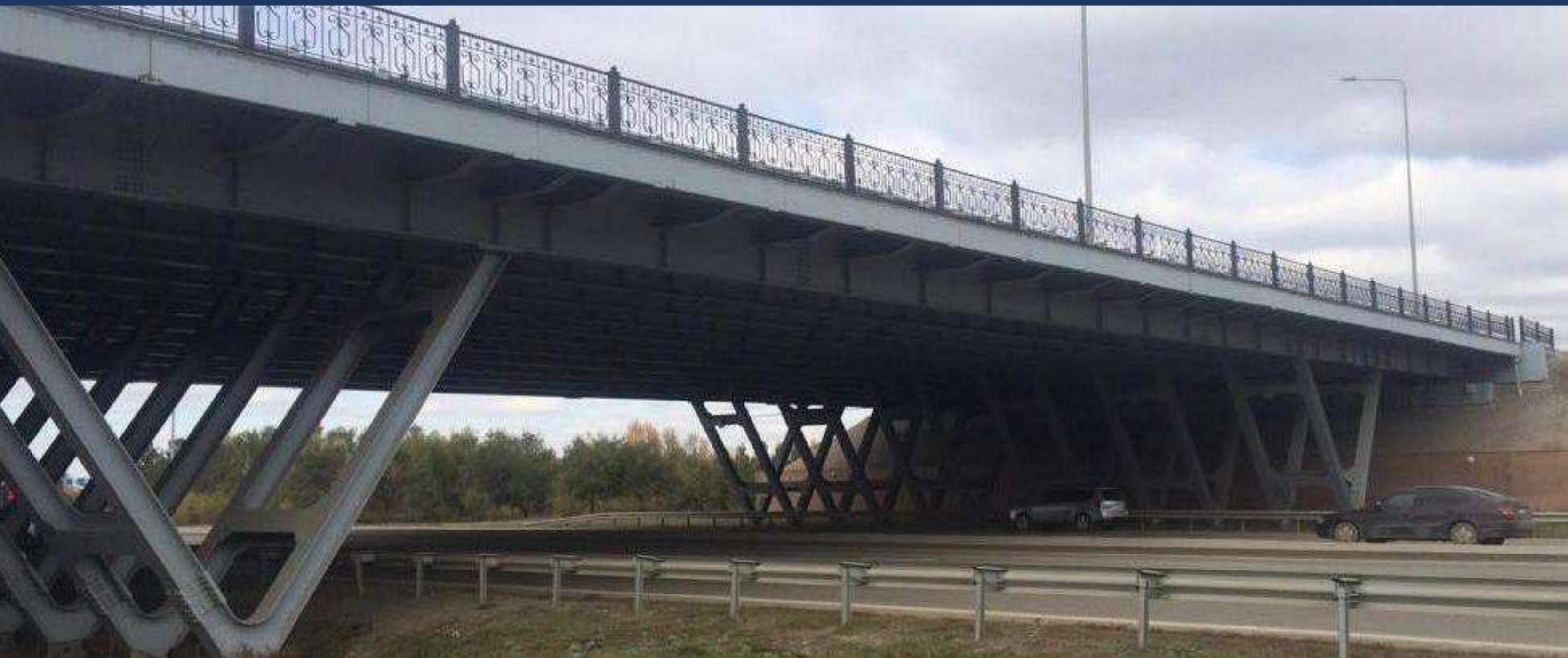
Разработана проектная документация металлического рамного неразрезного пролетного строения с V-образными металлическими опорами. Полная длина - 76,2 м, ширина - 17,7 м. Рамная конструкция моста. Схема  $15+44+15=76,2$  м. Высота стенки главных балок в свету 1,36 м.
