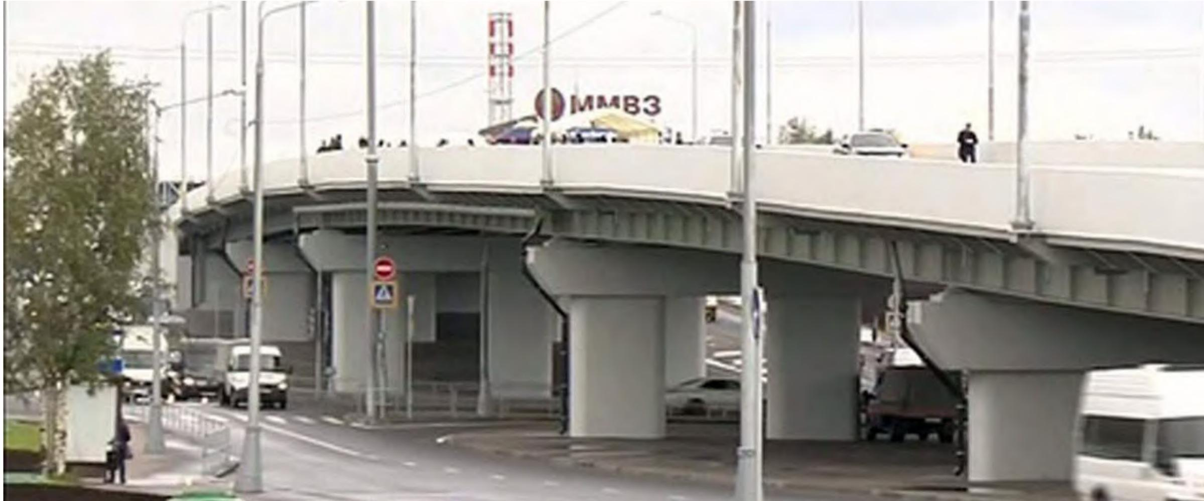
Главная особенность конструкции эстакады - металлические неразрезные пролетные строения с ортотропной плитой по схеме  $38,3+53,3+63,0+53,0+38,0$ . Общая длина - 246,1 м, ширина каждого - 26,6 м.
