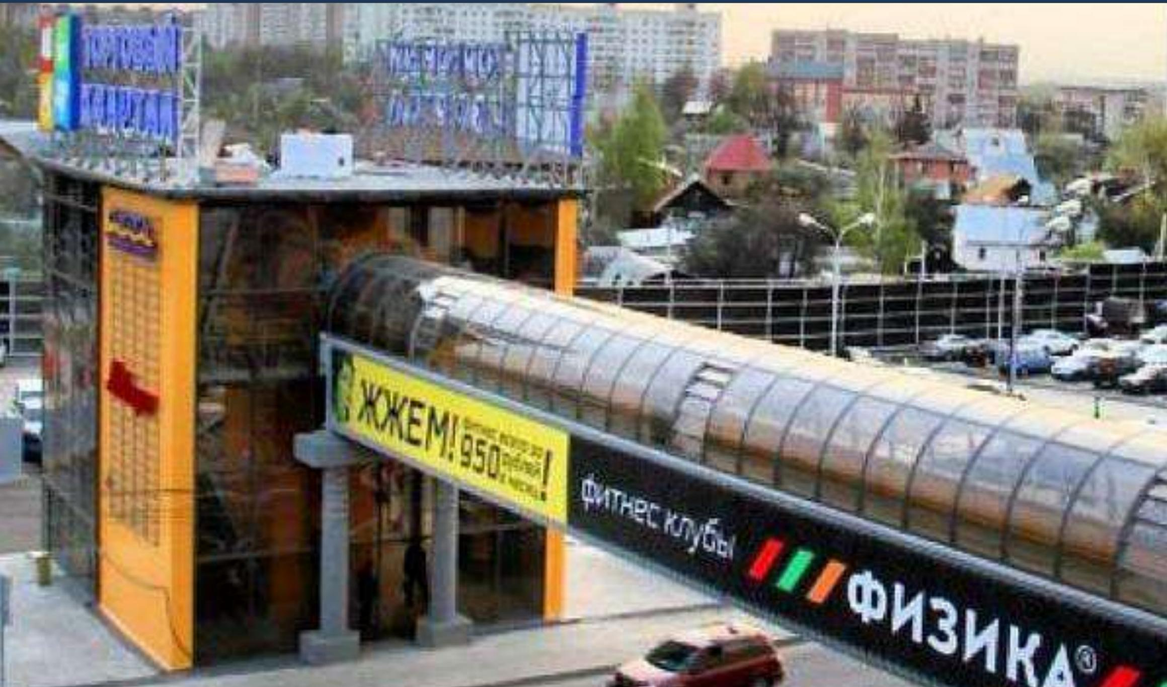
Пешеходный мост представляет собой металлическое разрезное пролетное строение с ортотропной плитой проходной части полной длиной 40 м.
