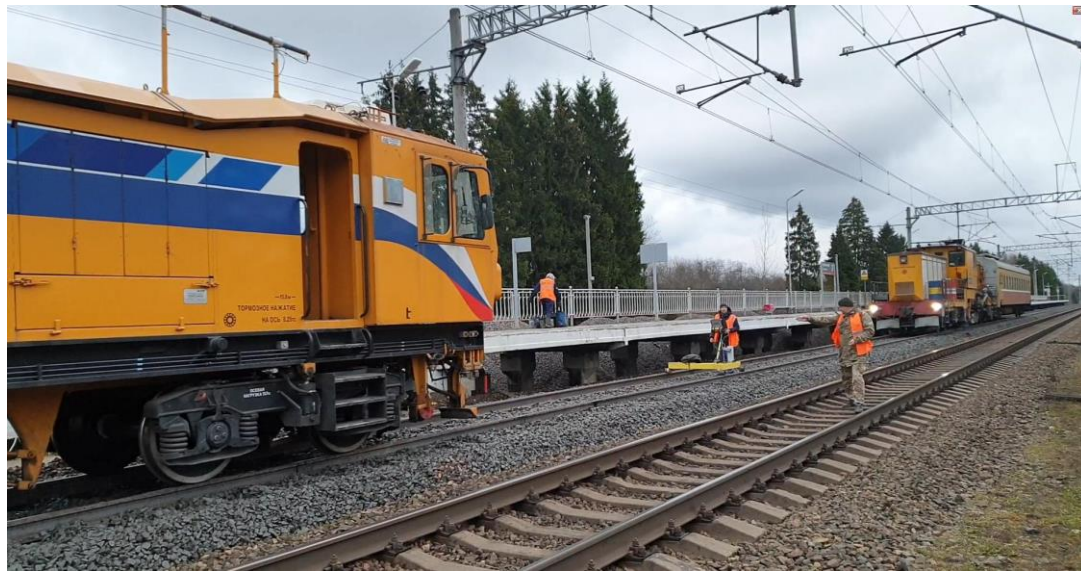
Ход выполнения ремонтных работ с применением специализированной техники
