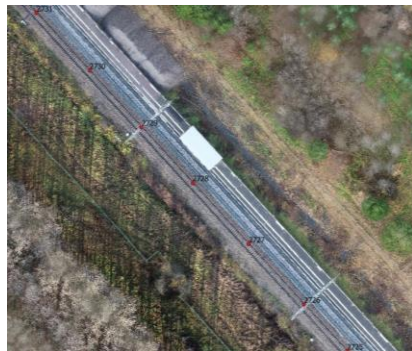
Ортофотоплан с нанесёнными отметками середины головки левого рельса первого пути
