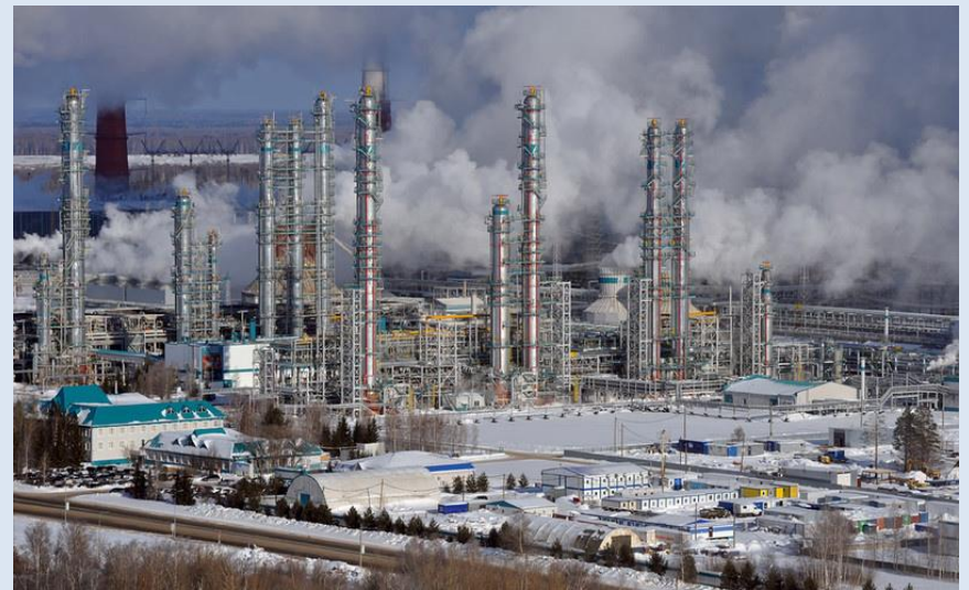
Нефтехимический комплекс компании СИБУР – «Западно-Сибирский комплекс глубокой переработки углеводородного сырья»
