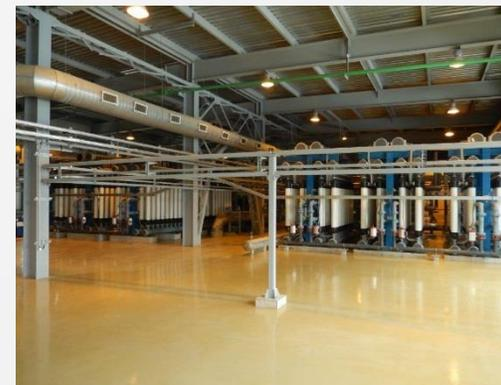
Одним из мероприятий, направленным на сокращение сброса сточных вод в водный объект (р. Кама), и экономию свежей речной воды является система оборотного водоснабжения в составе двух водооборотных циклов (далее ВОЦ-1; ВОЦ-2) для охлаждения технологического оборудования и агрегатов комплекса АМК мощностью 43736 м<sup>3</sup>/час.
