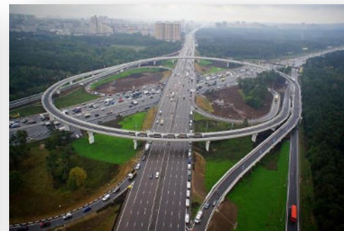
Реконструкция транспортных развязок
