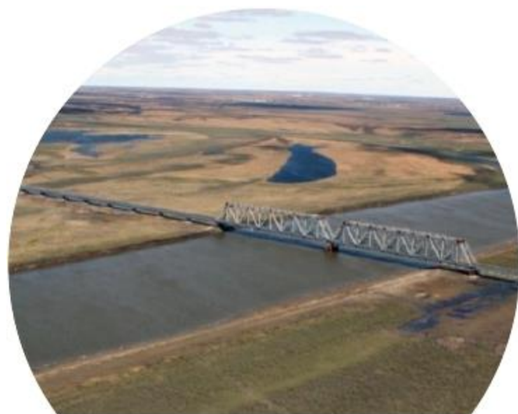
МОСТ ЧЕРЕЗ ЮРИБЕЙ (Ямало-Ненецкий АО, 2009)
