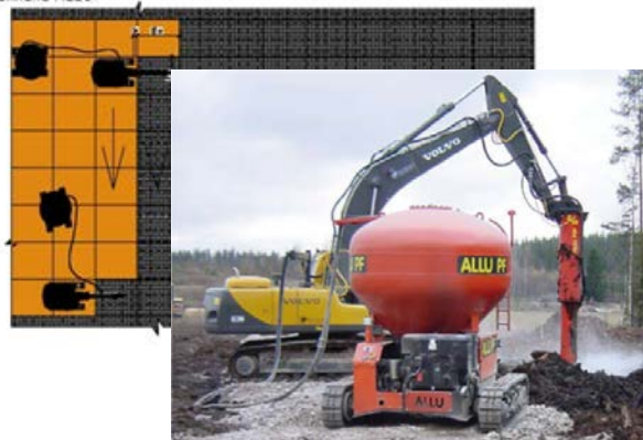
Стабилизация грунта при помощи техники ALLU
