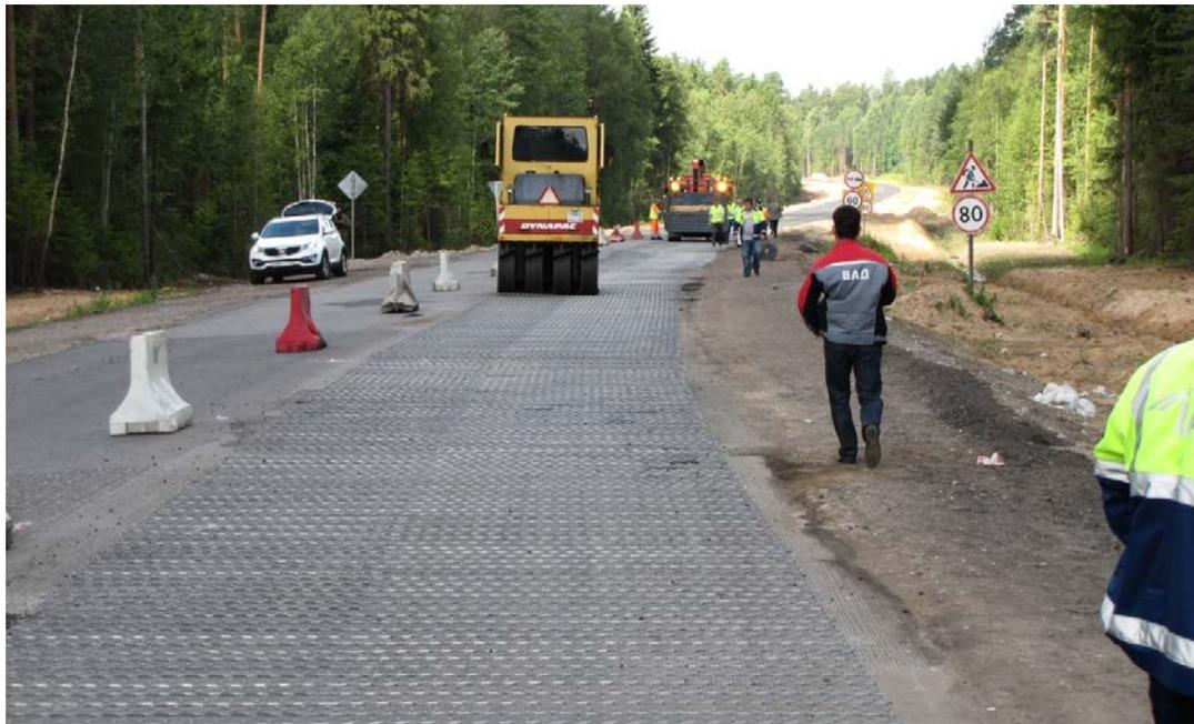
Окончательное закрепление сетки путем укладки слоя ЛЭМС
