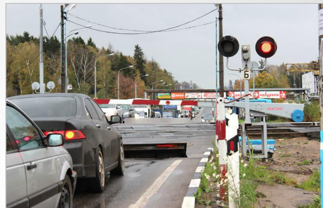
Видеонаблюдение на железнодорожных переездах
