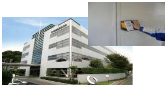
Контроль доступа к дата- центру
