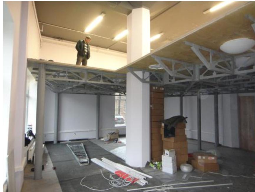
В конструкции платформы используются различные виды настила. Мы используем двухслойный настил из первого слоя сосок и второго слоя ДСП. Жесткость досок дает изменять размеры настила относительно металлокаркаса, подстраивая конфигурацию настила под требуемую проектом
