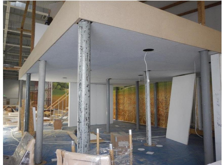
Под платформой может быть установлен стандартный потолок типа Армстронг, или сделан подшивной потолок. Потолок по периметру крепится к декоративному фризу, который скрывает силовой каркас перекрытия.
