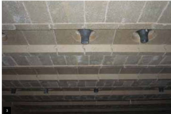
3 | Refractory kiln ceiling detail (Boyeur Leroux – France) Деталь потолка печи из огнеупорных материалов (Boyeur Leroux – Франция)
